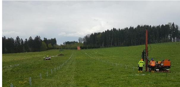
Abbildung 7: Hydraulikramme auf Ketten
