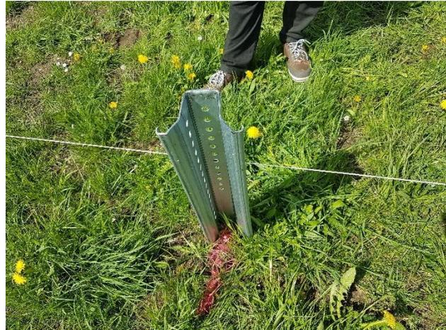
Abbildung 10: Rammfundament
